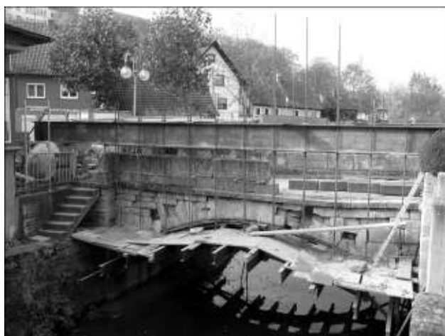
Im Stahlkorsett: die Hugobrücke
