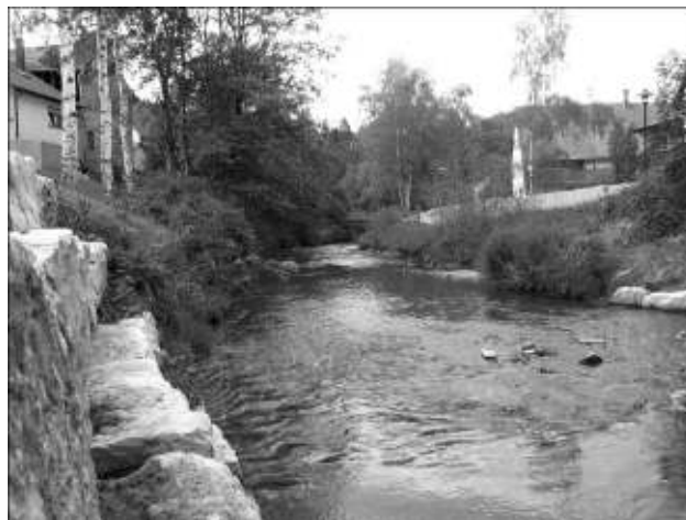
Hochwasserschutz entlang der Starzel
