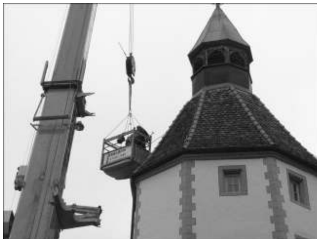
Dachsanierung am Unteren Turm
